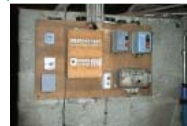
Installation électrique correcte
