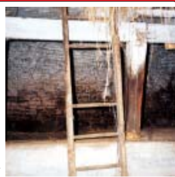
Echelle en mauvais état
